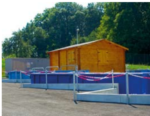
Nouvelle déchèterie de Michelbach-le-Haut
